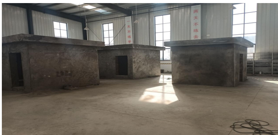
图 11 根据制定人才培养方案要求建造混凝土小屋
